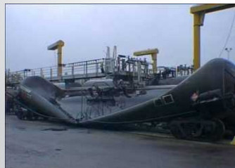
Deformação de costado de vaso de pressão
